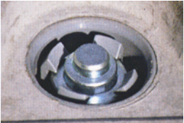
No. 4 ホルダーのツメがアンカー頭部にかかるまで完全に打ち込んで下さい。
