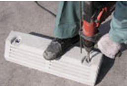
No. 1 本体を押さえつけながらホルダーの上から片側の穴あけをします。 φ12深さ55mm以上。
