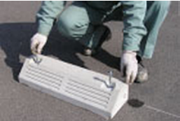
No. 1 ホルダーにアンカーピンを挿入します。
