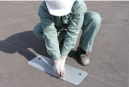
No. 1 計測、位置決めをします。 パーキングブロックは製品の破損を防ぐため平滑な設置面へ施工を行います。
