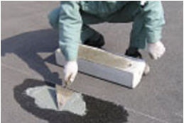
No. 4 パーキングボンドを中央部に厚みをもたせ接着面全体に塗布します。(※コンクリート舗装の場合は、アンカー付近を避けて塗して下さい。)
