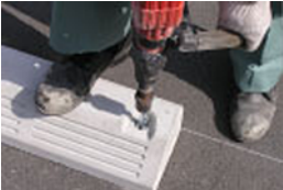
No. 2 本体を押さえつけながらプレーカーでアンカーピンを叩き込みます。
