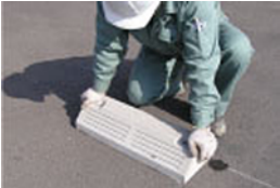
No. 5 ブロックを押さえつけながら定位置にセットします。
