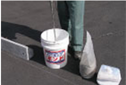
No. 3 パーキングボンドのセメント骨材とボンド液を練り混ぜます。(スランプはボンド液添加量で調整して下さい。)
