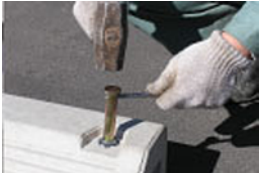
No. 3 ハンマーで打ち込む場合はφ10以下の下穴をあけた後に叩き込みます。
