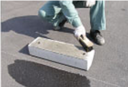
No. 2 ブロック及び舗装の接着面を掃除し、ブロック接着面に水打ちをします。(※ドライアウト防止の為)
