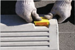
No. 5 反射レンズを正面に向けホールキャップをはめ込みます。
