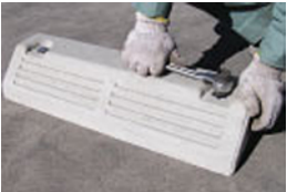
No. 4 ボルトを締め込みます。(ボルトの締め込みによりアンカーが拡張します。) ※締めきれない場合はボルト先端を適度に切り落として下さい。
