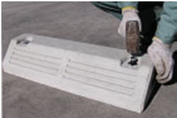
No. 3 アンカーボルトを軽く叩き込みます。(締めシロガ2~3mm位残るのが適切) ※ホルダーのツメがアンカーの樹脂座金にかかるのを確認下さい。
