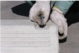
No. 2 アンカー付ボルトを挿入します。
