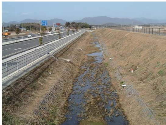
(三面張り水路)
