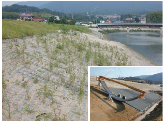
（施工半年後の植生状況）
