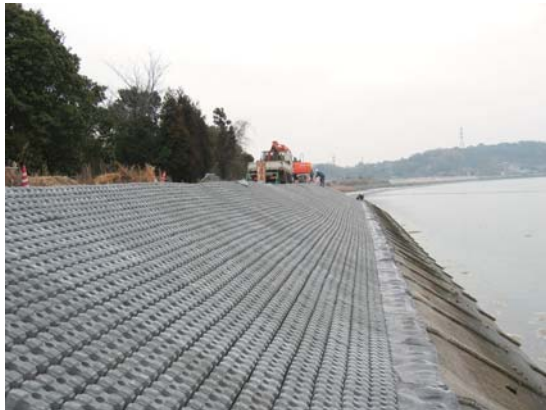
（災害復旧工事）
