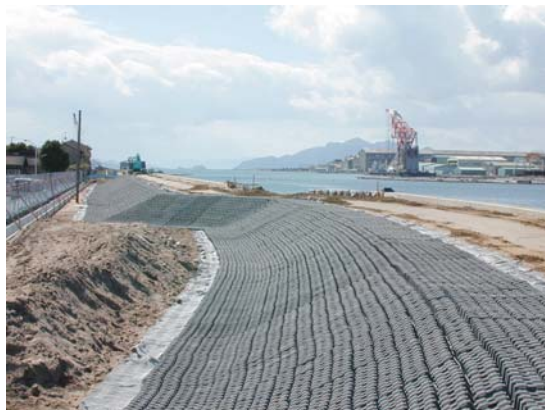
(高潮堤防裏のり保護 施工後覆土)
