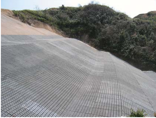
（付け替え道路のり面保護） [国土交通省斐伊川神戸川総合開発工事事務所]
