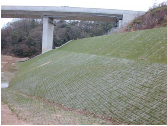
（植生工併用） [宇部土木建築事務所]
