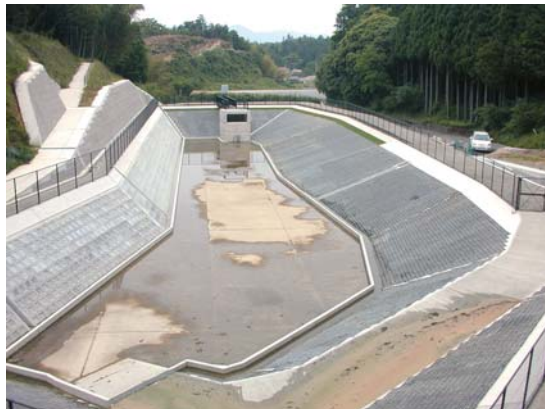
[出雲県土整備事務所]
