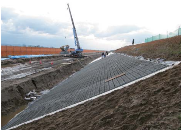
斐伊川西代堤防強化工事（島根県）
