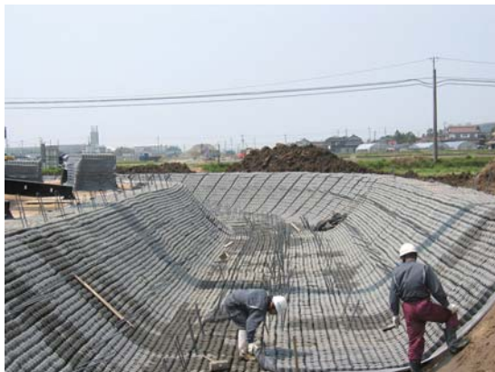
(三面張り水路)
